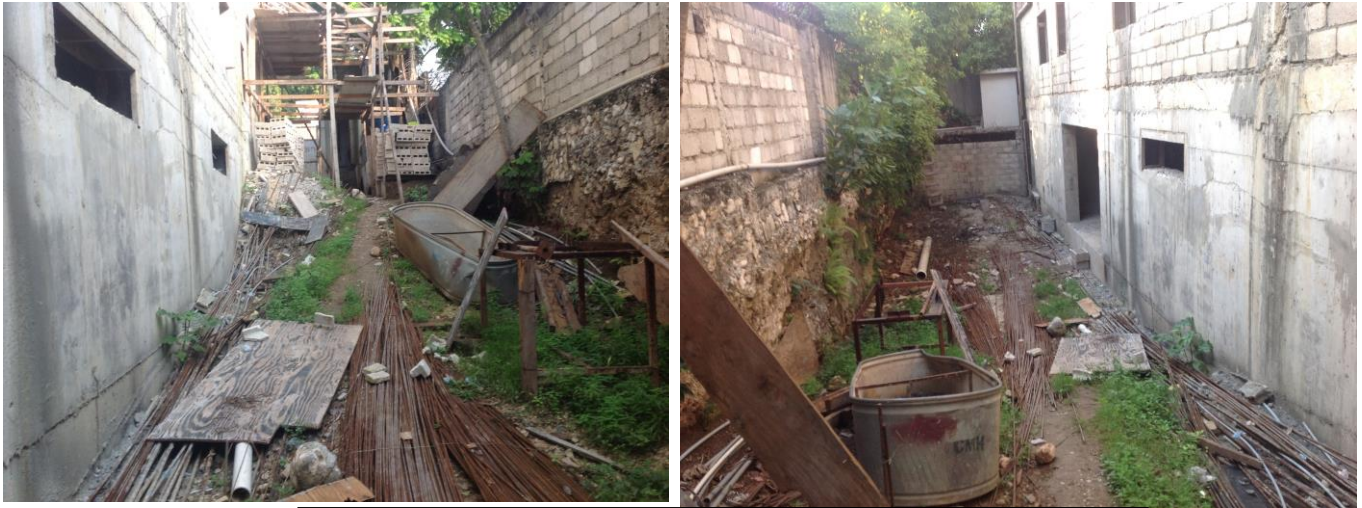
Encombrement de la zone principale de circulation du chantier
